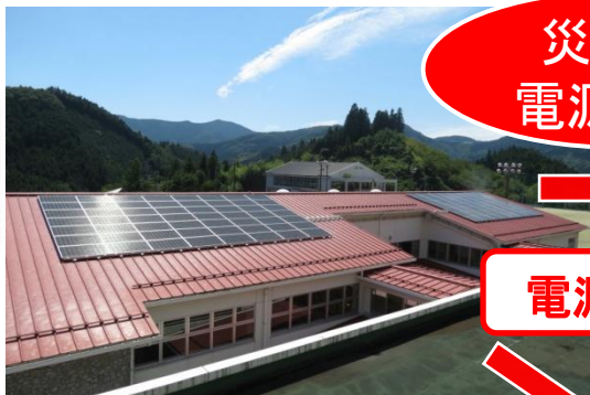
太陽光発電設備 (61.6kw)
