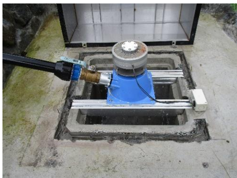
小水力発電設備 (0.2kw)
